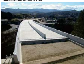
飯橋道路施工状況
