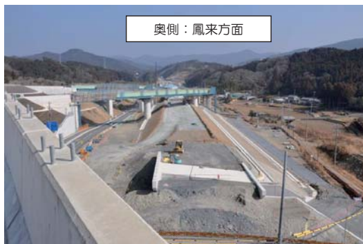
引佐JCT(新東名から引佐連絡路へ入る高架橋の上)から、引佐北IC方面を望む (H23.2.7現在)
