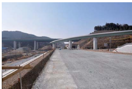
三遠道路の上で、引佐北IC(仮称)側から引佐JCTを望む (H23.2.7現在)
