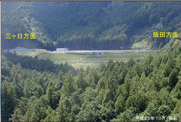
⑦ 大島地区(盛土部)
