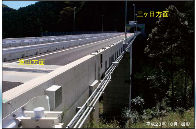
⑧ 名号高架橋
