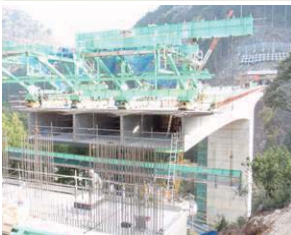
三遠道路施工状況
