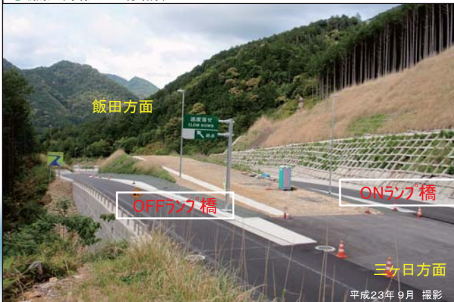
⑨ 鳳来IC(本線・ランプ分岐部)
