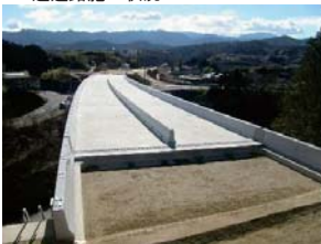
飯橋道路施工状況
