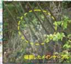
損傷箇所(ケーブルの破断)
