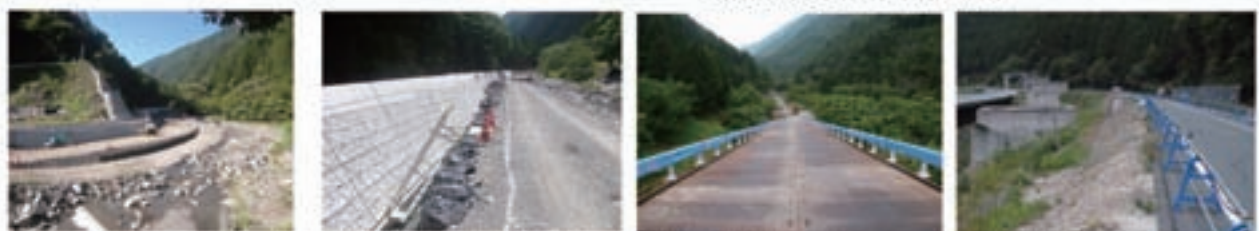
① 鳥川原橋付近 工事用道路施工状況 ② 大型ブロック積み 施工状況 ③ 中間進入仮橋 施工状況 ④ 本線終点側 4
