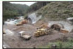
③佐久間第1トンネル(入口)
