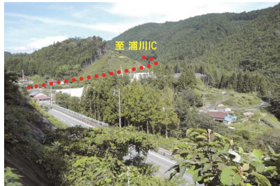
東栄IC（仮称）付近
