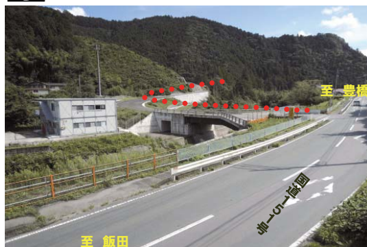
東栄IC（仮称）付近
