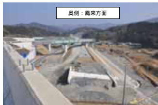
三遠道路浜松いなさJCT(新東名から引佐連絡道路へ入る高架橋の上)から、引佐北IC方面を望む(H23.2.7現在)
