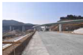
三遠道路引佐北IC(仮称)側から引佐JCT(新東名)を望む(H23.2.7現在)
