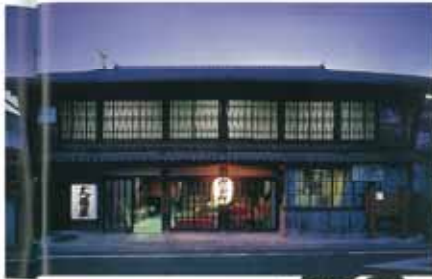
旅籠・大横屋(東海道 赤坂宿) 1715〜16年(正徳5〜6)頃の建築で、旧屋号を継ぎと称す。間口9間、奥行き23間ほどの大横屋であり、広東の描いた浮世絵の面影を色濃く残している。東海道沿いで唯一現在も営業を続けている旅館。 ◎ 彦根市赤坂町127 電話 0533-87-2430
