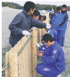
堆砂垣の設置
