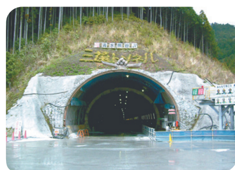
三遠トンネル引佐側坑口
