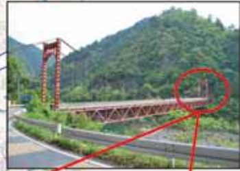
損傷箇所(ケーブルの破断)
