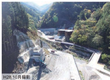
小嵐IC周辺のトンネル工事
