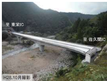
H28.10月撮影 おおちせ がわ 大干瀬川橋(仮称)
