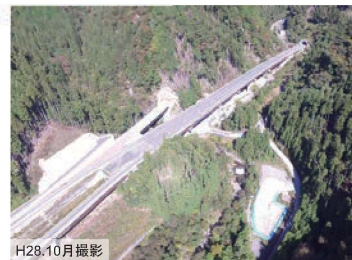
水窪北IC周辺の改良工事
