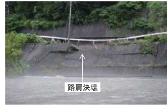
国道418号(長野県天龍村折立付近) (H22.7)
