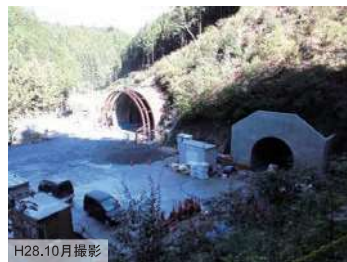
H28.10月撮影 佐久間第1トンネル(仮称)東栄側坑口
