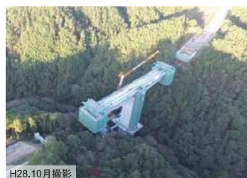
② 龍江IC周辺の橋梁工事
