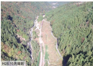
小嵐IC周辺の改良工事
