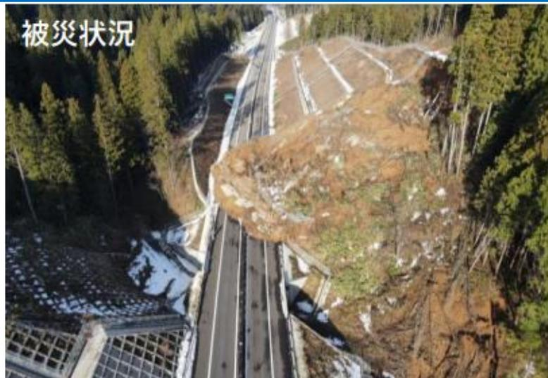
法面崩壊による土砂流出
